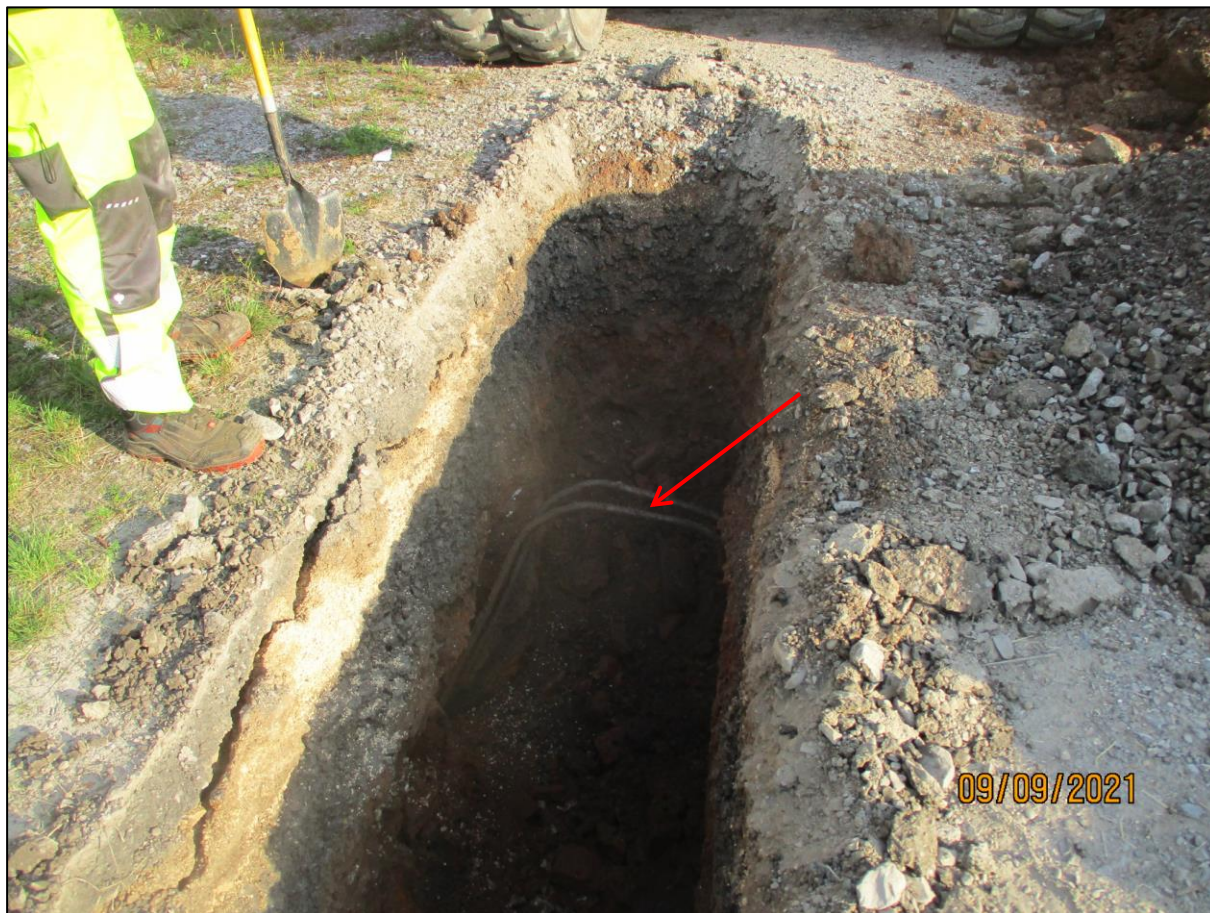
Abbildung 9-1: Blick in den Schurf 1 mit den frei gelegten Leitungen (Leitungen sind durch den Bagger verbogen; Heizöl ist nicht ausgelaufen)
