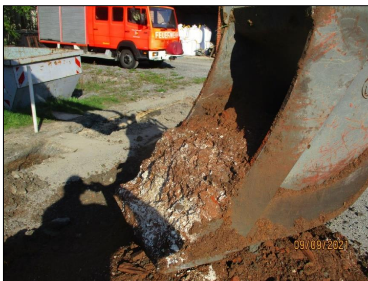
Abbildung 5-2: Baggerschurf 1, „weiß-grau Auffüllung“
